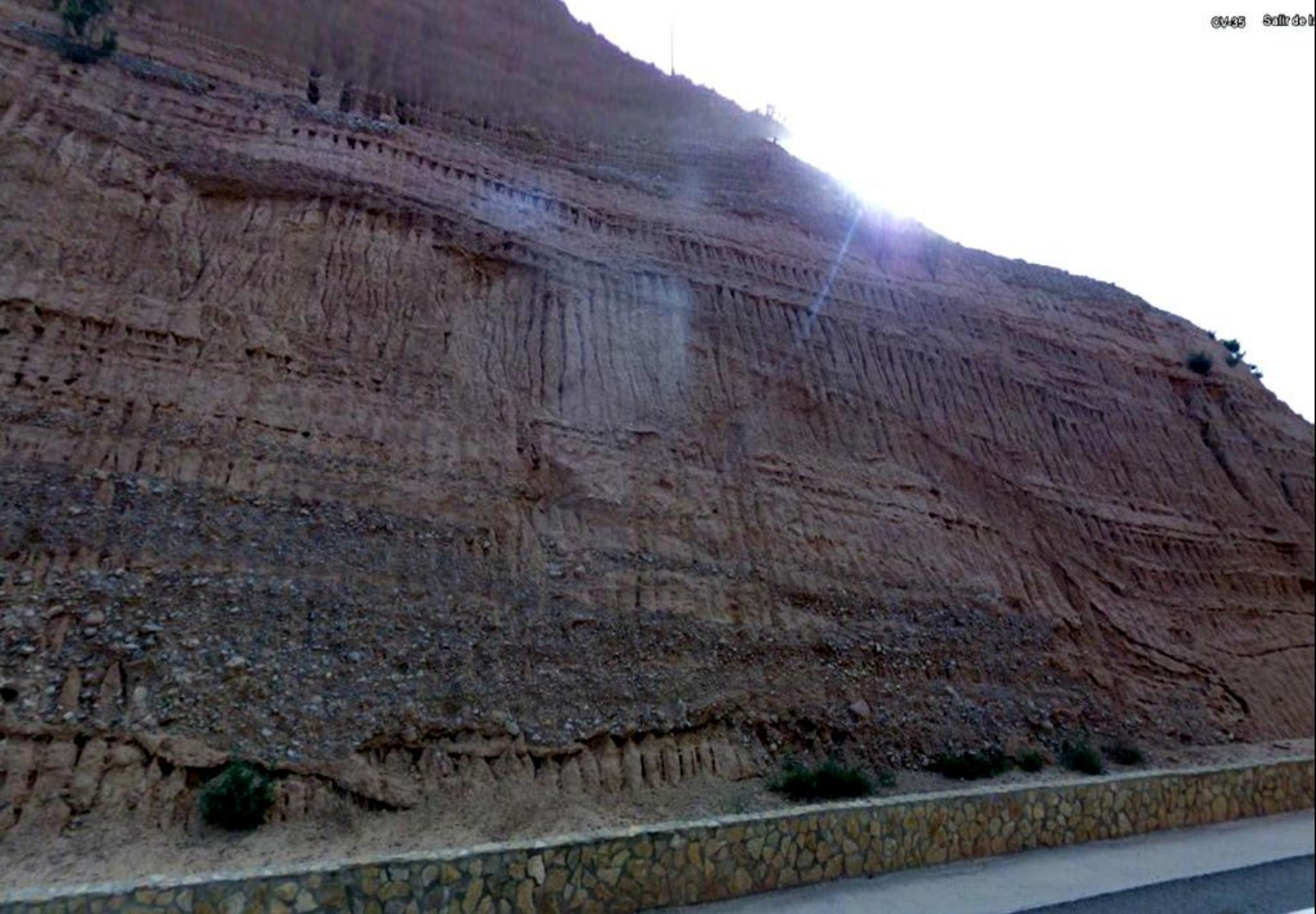
Hacia zona 4. Talud de depósitos fluviales, con gravas, arenas limos... del Río Turia. Muro –distancia- protección de carretera. La siguiente es continuación de este talud
