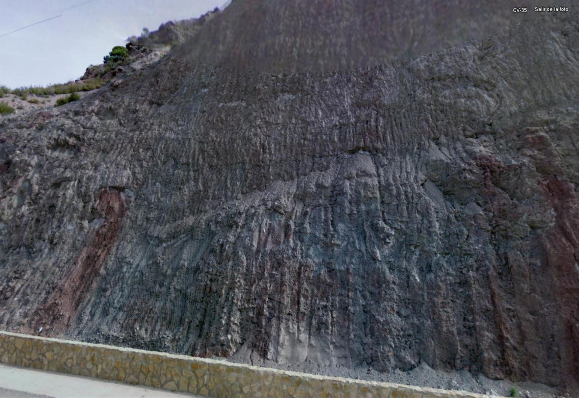
Hacia [zona 4](#). En esquina izquierda imagen anterior. Materiales del Triásico- Keuper. De colores intensos- arcillas, arenas, margas con yeso- con tela metálica y muro para evitar caídas en carretera
